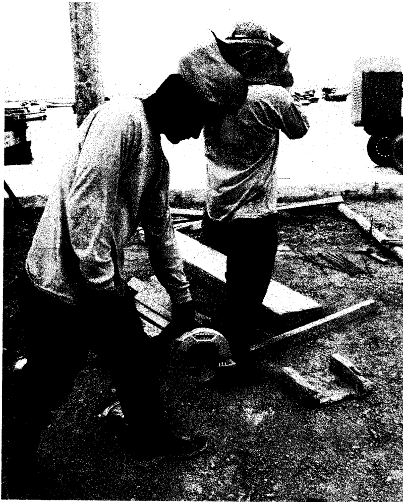
Realizando el encofrado de losa en zona de maniobras
