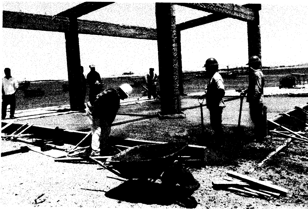
Llenado con concreto de losa
