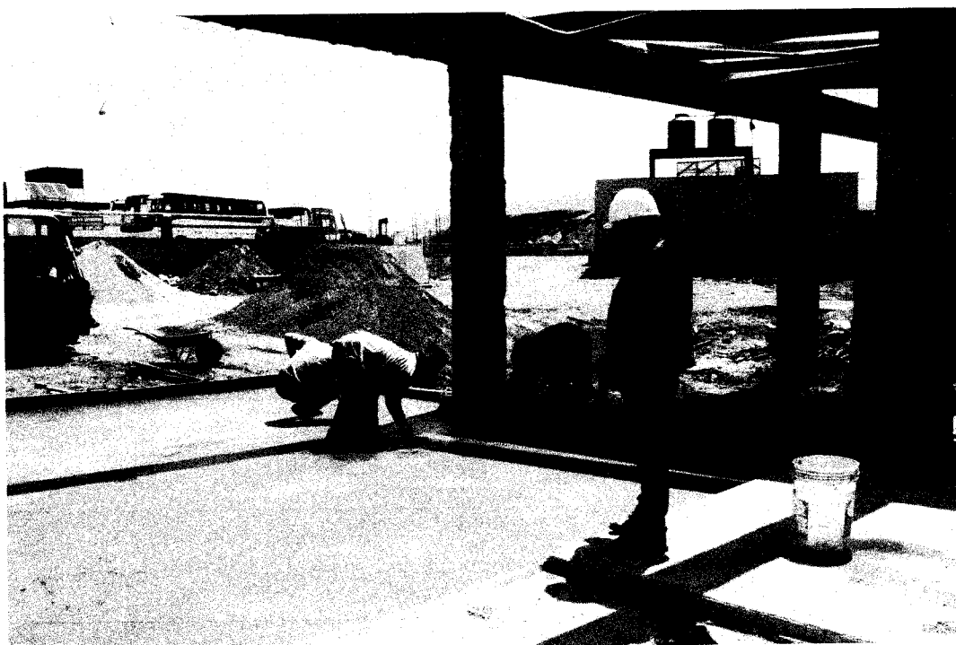
Nivelando la losa
