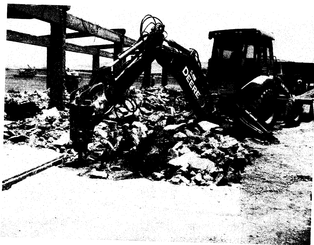
Demolición con maquinaria en zona de maniobras
