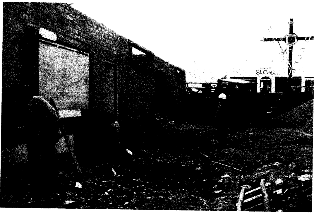
Culminando el descalificado de la parte delantera del local multiusos y demolición de vereda
