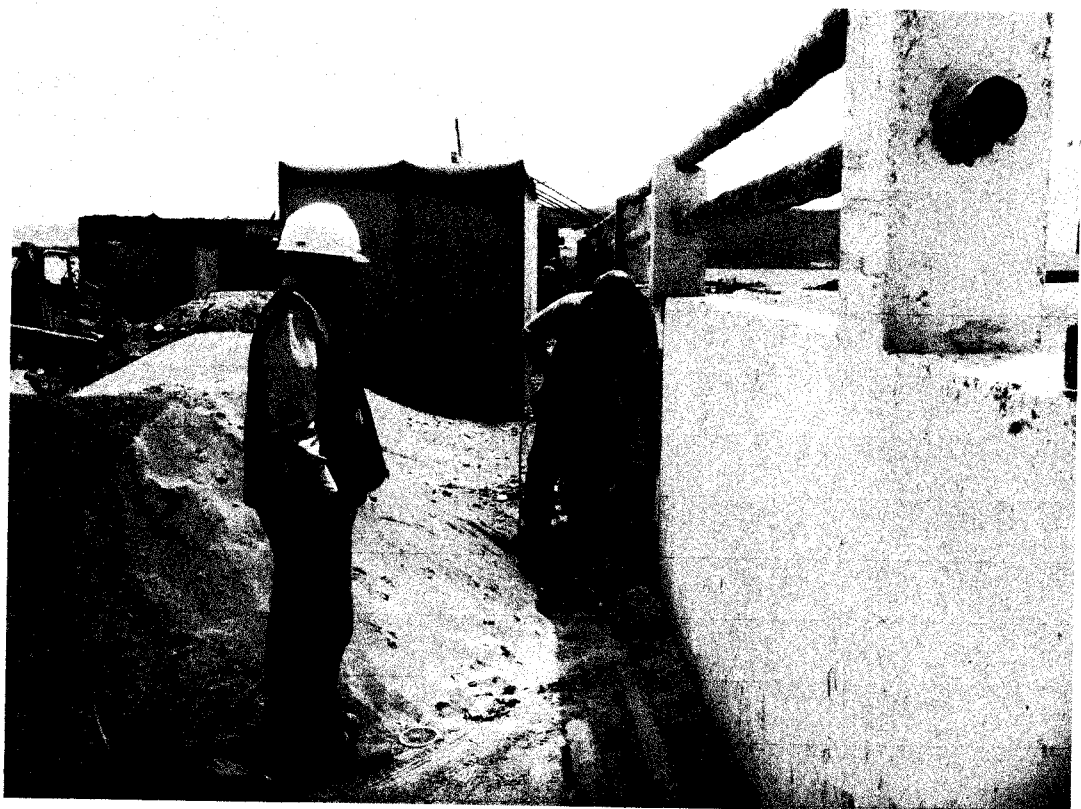
Descalificado en cerco perimétrico
