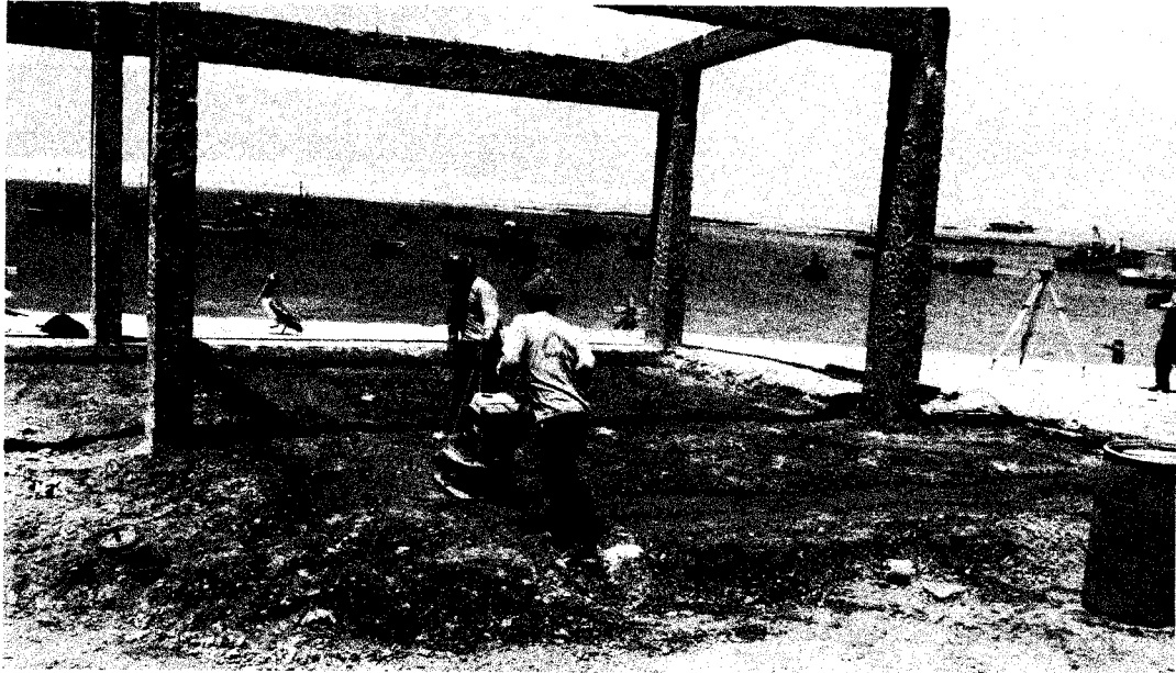
Realizando la compactación de La base granular
