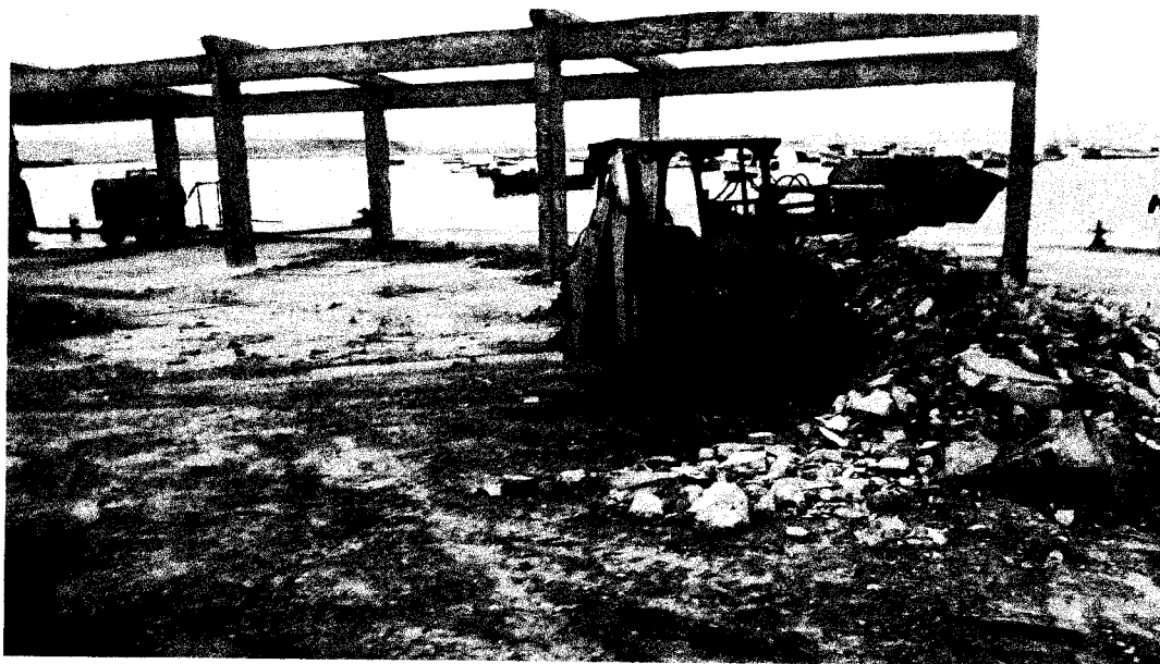
Eliminación de material excedente de losa en zona de maniobras
