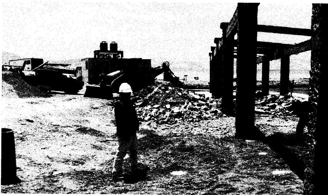
Demolición de losa en zona de maniobras
