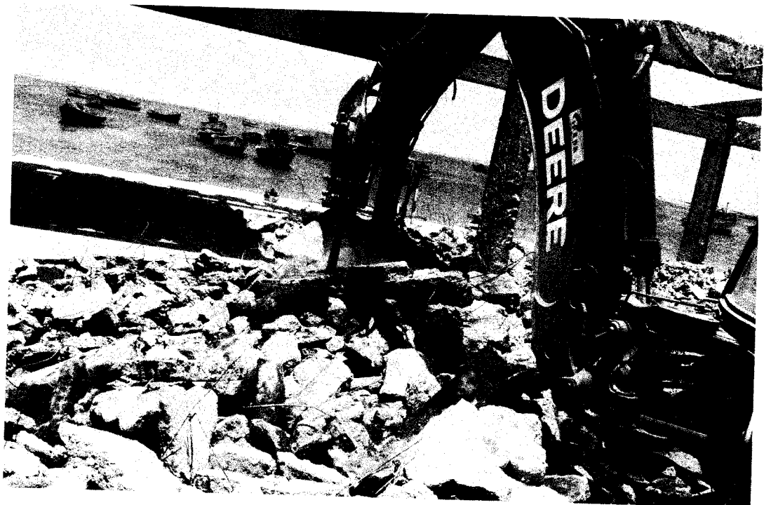
Demolición de losa en zona de maniobras
