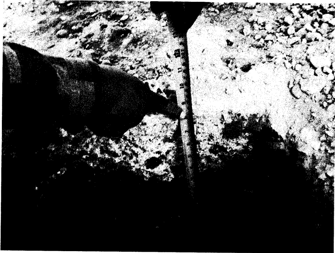
Altura de la losa en zona de maniobras a demoler
